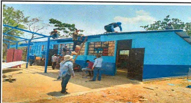
Foto 4: Instalacion del entechado.
