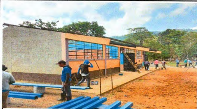
Foto1: Desmontado del entechado viejo.
