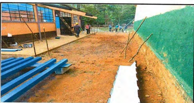
Foto 5: Preparacion para el area de entortado del patio
