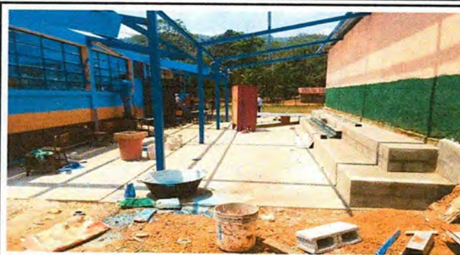
Foto 2: Aplicación del entortado del patio.
