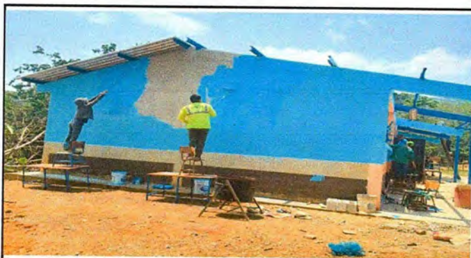
Foto 3: Aplicación de la pintura.
