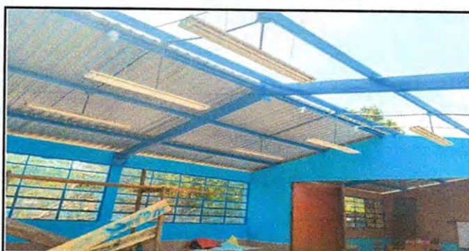
Foto 6: Instalacion del entechado nuevo.
